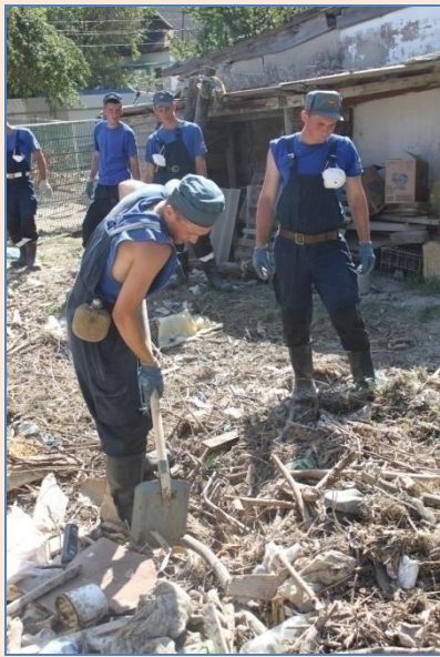
Ликвидация последствий наводнения в г.Крымске Краснодарского края (июль 2012 г.)
