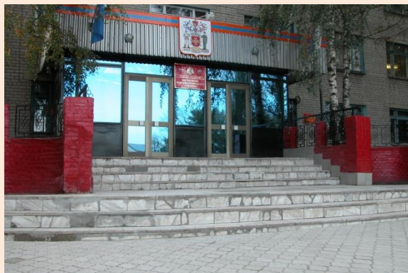
Входная группа Воронежского пожарно-технического училища
